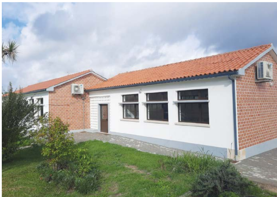
• As obras de adaptação da antiga escola custaram 110 mil euros
