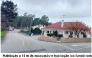
Habitação a 15 m de escavação e habitação (ao fundo) sob escavação, ao km 100+550
