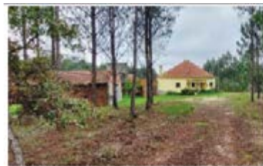
Habitação e anexos em zona de escavação, ao km 100+270
