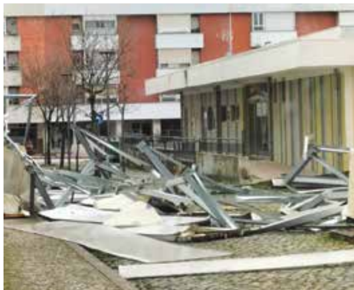
• As estruturas metálicas junto ao Mercado Municipal vieram parar ao chão
